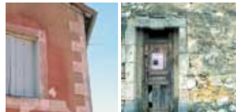
Chaîne harpée peinte Joints "beurrés"
