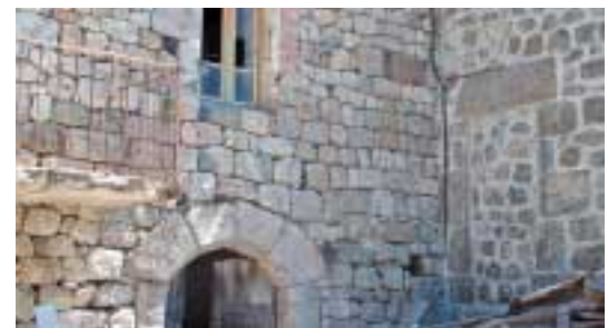
Pierre non jointée et pierre jointée à la chaux
