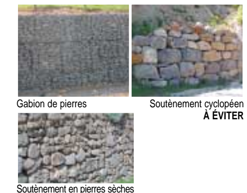
Soutènement en pierres sèches
