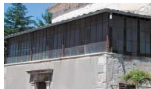
Véranda ancienne en métal, Lalevade-d'Ardèche
