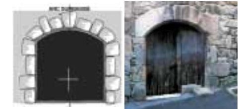
L'arc surbaissé est une portion d'arc de cercle posé sur les jambages. Arc surbaissé, Montpezat-sous-Bauzon
