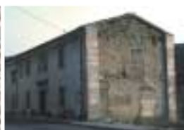
Renforts en béton après une démolition partielle
