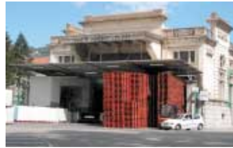
Usine d'embouteillage, Vals-les-Bains
