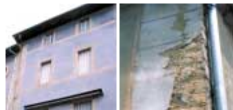
Structure soulignée Chaîne droite peinte détail
