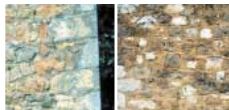
Chaîne taillée et remplissage Joints "beurrés"
