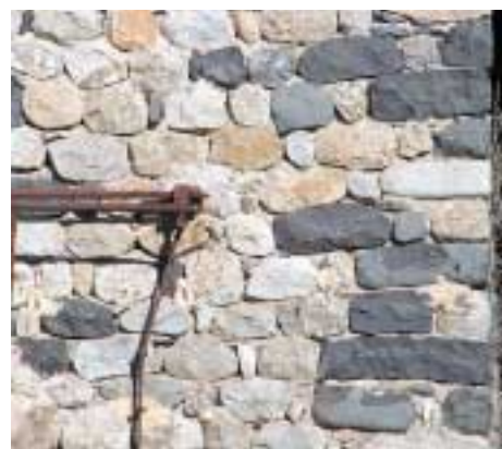
Galets refendus, Lalevade d'Ardèche. La diversité des pierres témoigne des économies de transport de matériaux et donne un aperçu de la géologie de la vallée (basalte et granites notamment).
