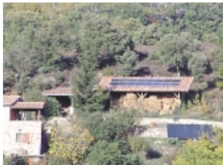
Panneaux solaires sur un bâtiment agricole, Rocles.
