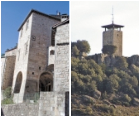
Maison à Largentière Tour de Brison Exemples de la modernité et de l'innovation de l'architecture traditionnelle.
