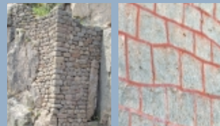
Mur à deux parements
