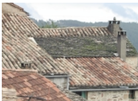
Tuile mécanique, tuile canal et lauzes, Faunières
