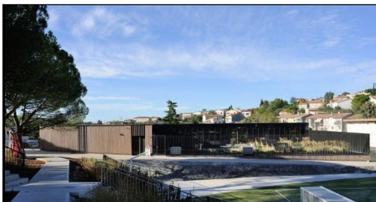
« Photos du Pôle de Services, côté terrain sportif et Place
